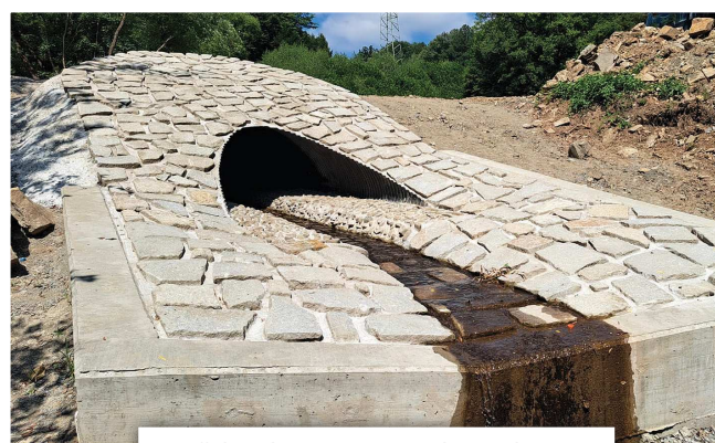
Vnitřek tubusu pro Sojný potok je vydlážděn tak, aby vyhovoval pohybu žab.
