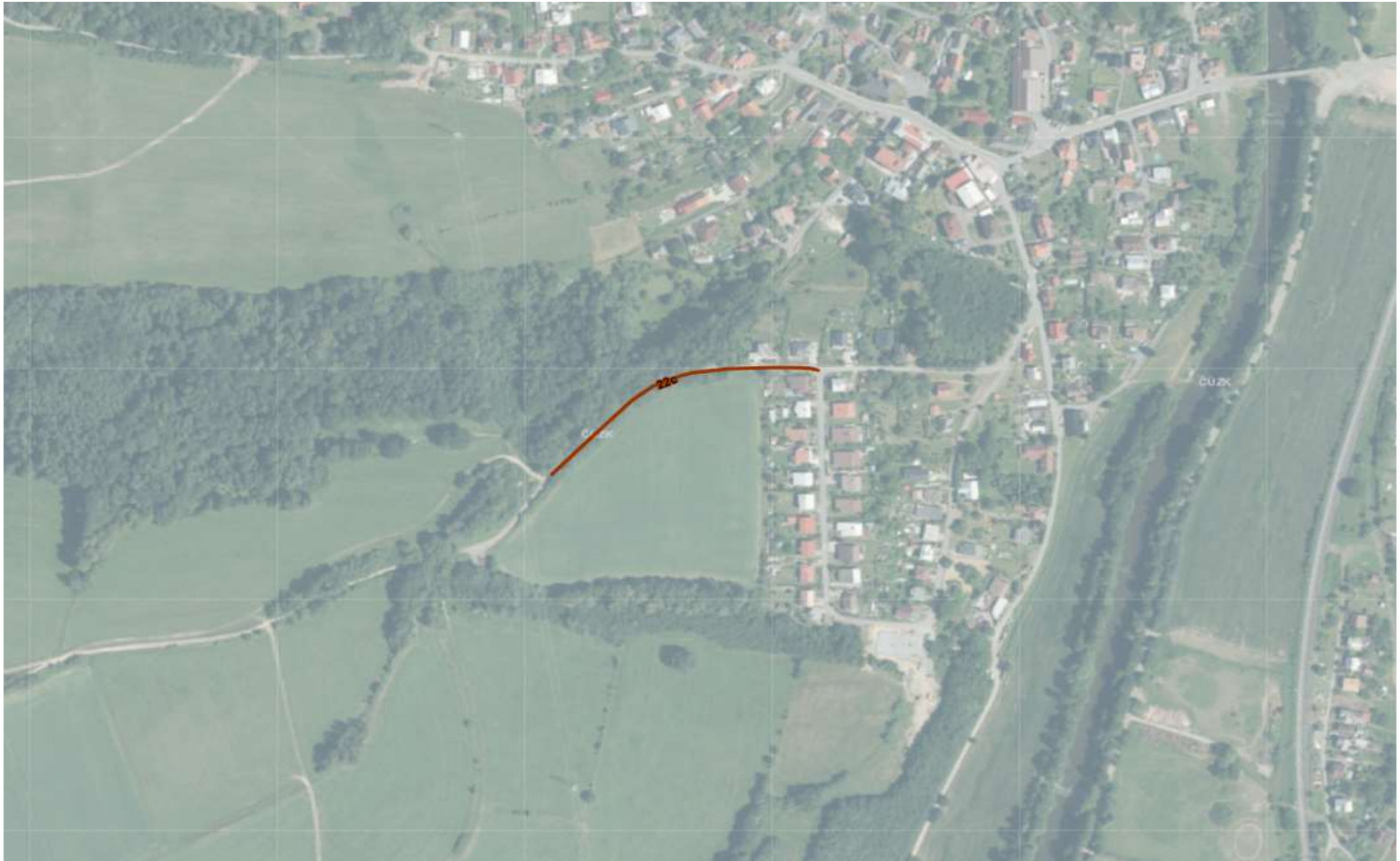
Obrázek A.4.1.22: Místní komunikace III. třídy (22c)
