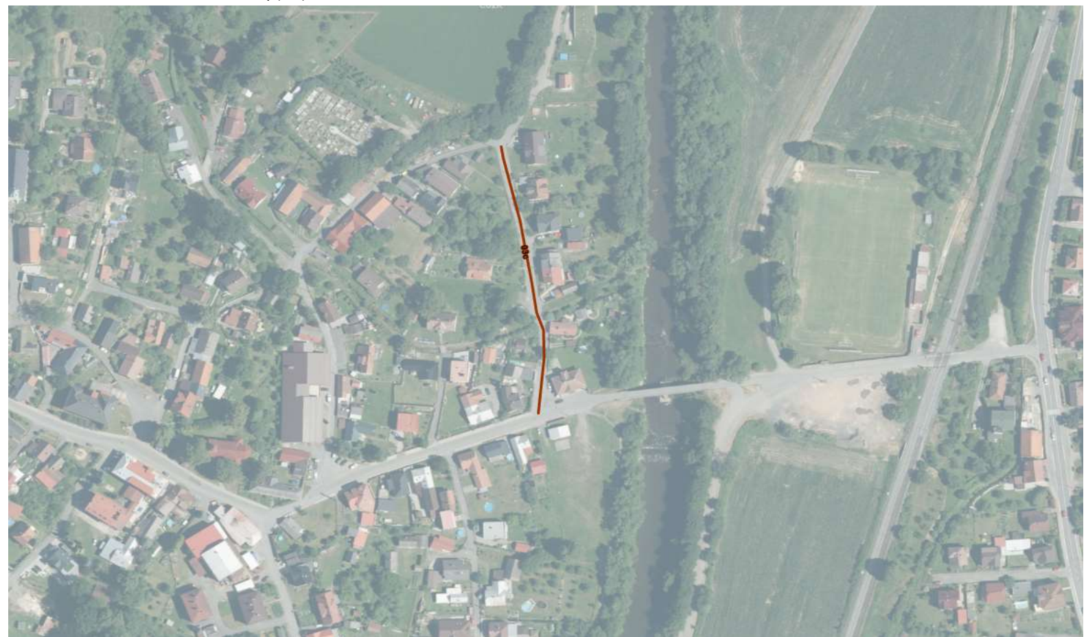
Obrázek A.4.1.3: Místní komunikace III. třídy (03c)
