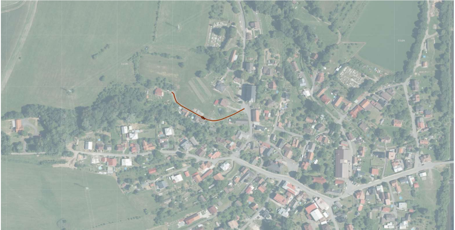
Obrázek A.4.1.12: Místní komunikace III. třídy (12c)
