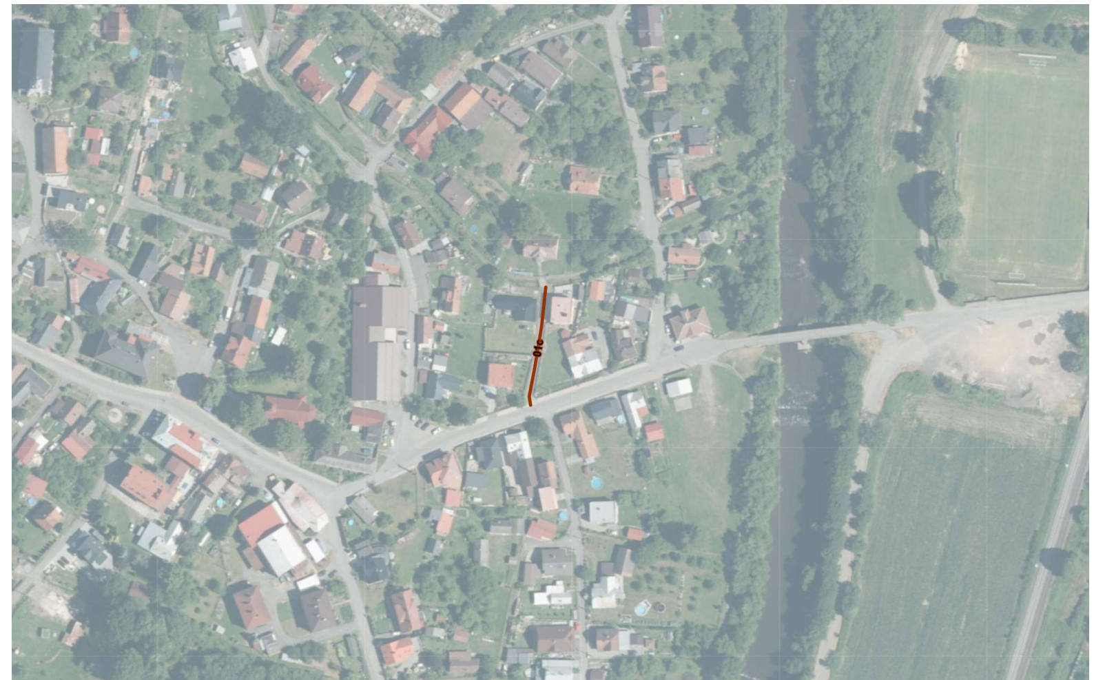
Obrázek A.4.1.1: Místní komunikace III. třídy (01c)
