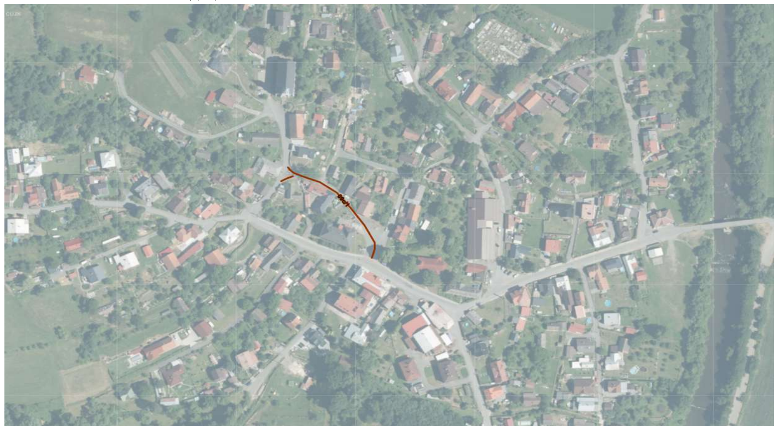
Obrázek A.4.1.9: Místní komunikace III. třídy (09c)
