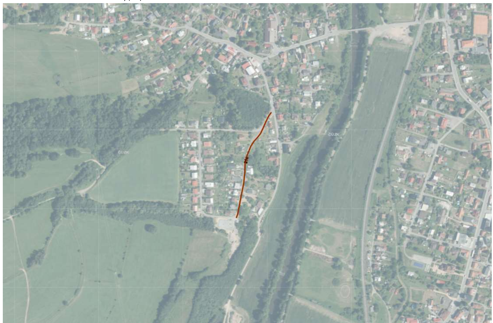
Obrázek A.4.1.21: Místní komunikace III. třídy (21c)
